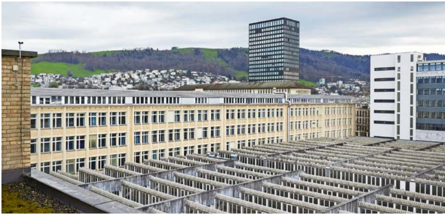
Das Bestandesgebäude am Zählerweg auf dem Landis & Gyr-Areal in Zug.
