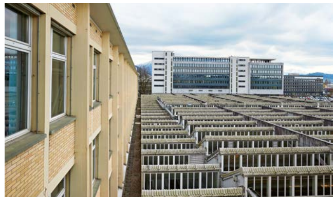
Ziel ist es, Bauteile und Materialien aus den Altbauten nach Möglichkeit wieder im Projekt einzusetzen.
