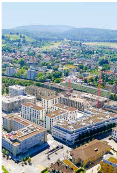
IM LENZ, LENZBURG (AG) FLÄCHE: 61 400 M 2 AUSFÜHRUNG: 2013 – 2018
