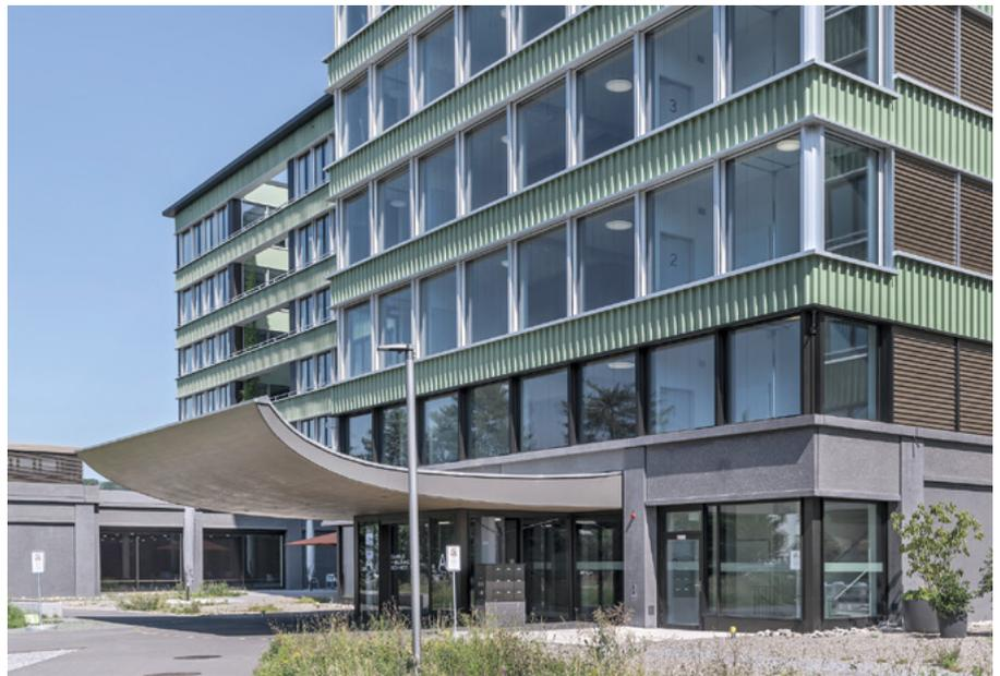
Die moderne Architektur sorgt für Transparenz und Durchlässigkeit zwischen den Ausbildungen und Studiengängen. Das Gebäude aus dem Jahr 1971 wurde totalsaniert. Es erfolgten ausserdem eine Erdbebenertüchtigung und eine komplette Schadstoffsanierung. Während von UG4 bis OG4 die bestehende Beton-Tragstruktur maximal behalten wurde, erfolgten für OG5 und OG6 ein Rückbau und ein Neubau.
