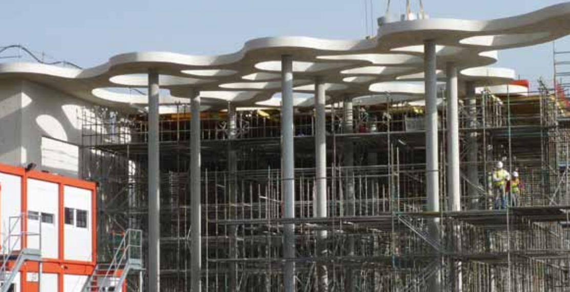
Die Pergola – ein 40 cm starkes „Betonblatt“ von 4'500 m 2 und mit einem Gewicht von 3'000 Tonnen – liegt auf 96 Pfosten von 9 bis 18 Metern Höhe auf.
